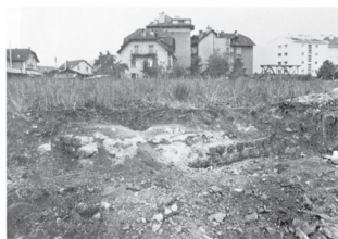
Dans un sondage (chantier n°77) av. du Parc des Sports mur de la Curie en petit appareil jointé avec arase en briques trian- gulaires (photo de 1964)
