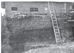
Au Bel-Air B (chantier n°71) 9-11 bd. de la Rocade coupe de la voie cardinale occiden- tale montrant un macadam de 0,90 m d'épaisseur (photo de 1963)
