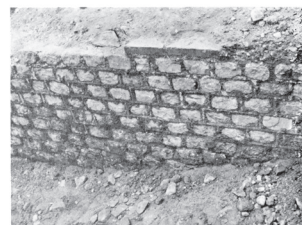
Dans un sondage (chantier n°77) av. du Parc des Sports mur de la Curie en petit appareil jointé avec arase en briques trian- gulaires (photo de 1964)
