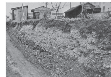
Sur la Rocade (chantier n°58) bd. de la Rocade voie cardinale occidentale coupée en écharpe par la tranchée de l'égout. Les recharges successives de gravier peuvent être confondues avec un alluvionnement naturel (photo de 1960)
